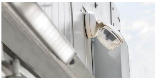
Éclairage extérieur avec détecteur de mouvement
