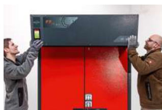
2 Placer le module de ventilation sur l'armoire et établir la connexion
